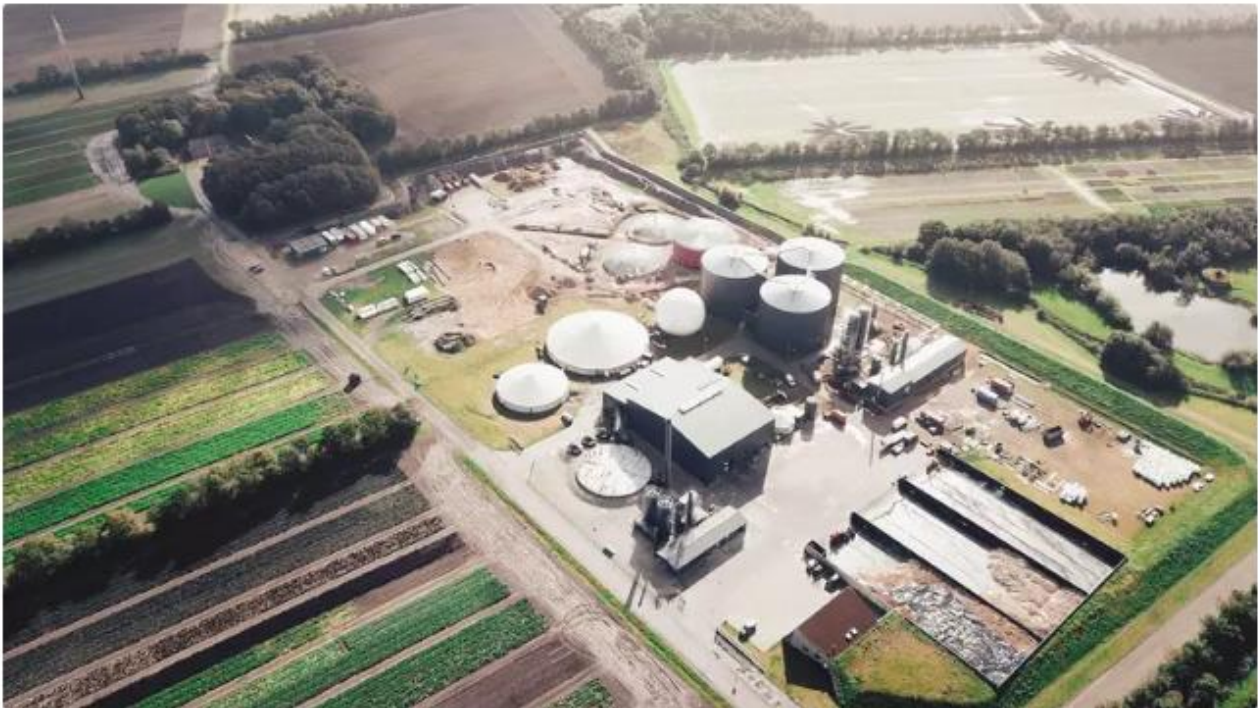
Die Biogasanlage in Brande produziert jährlich 18 Mio. Kubikmeter Biogas. (Bildquelle: Ammongas / Månsson A/S)
