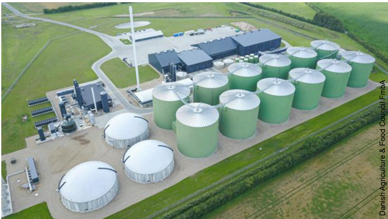
Die SBS Kipleve mit Sitz in Aabenraa gehört zu den größten Biogasanlagen weltweit.
