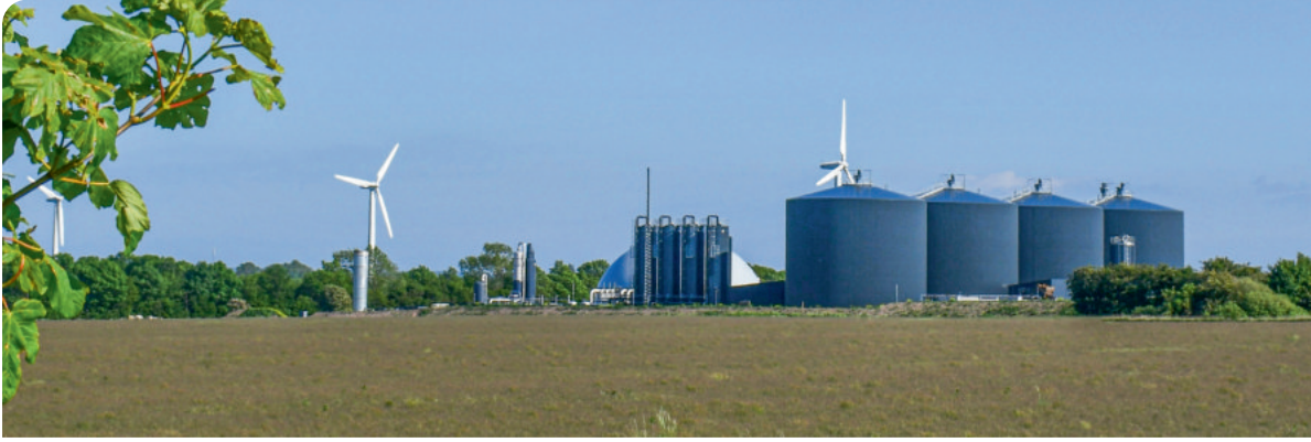
Eine typische dänische Biogasanlage Namens Shell Koeng Biogas, die sich bei Vordingborg auf Seeland befindet. Foto: Dänischer Biogasverband
